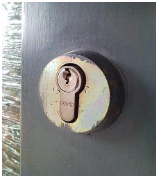
richtig: Sicherheitsschloss / bündige Blende und Blende ist nicht abschraubbar
